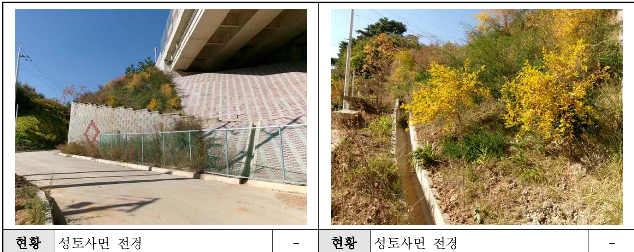
【사진 6.5】 옹벽 상단부 현황
