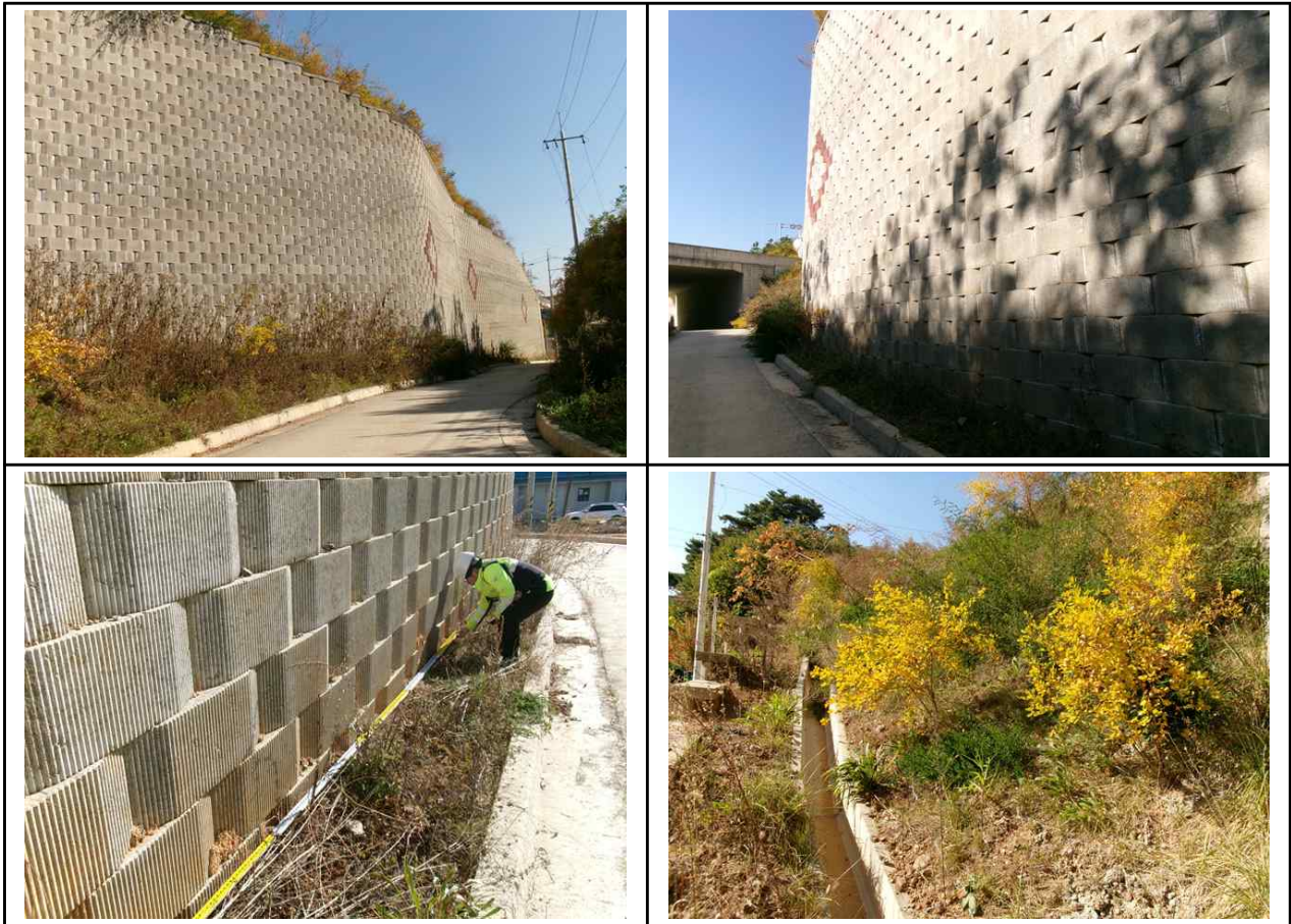
【그림 6.10】 외관조사 전경
